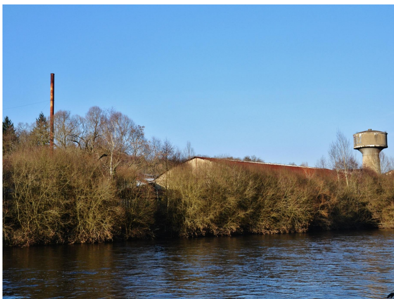
Image : Cheminée, bâtiments et château d'eau de l'ancienne usine de caoutchouc Watelez, au Palais-sur-Vienne (Haute-Vienne, France). Par Babsy, Travail personnel, CC BY-SA 3.0, via Wikimedia Commons .
