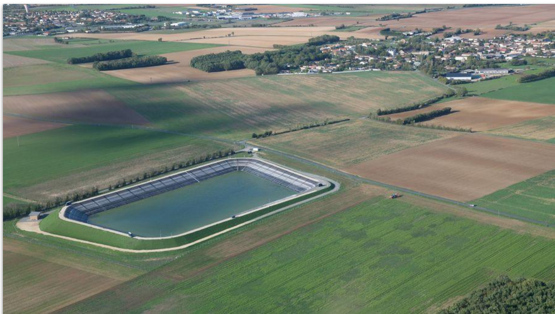
Une retenue d'eau à Mauzé-sur-le-Mignon (Deux-Sèvres), le 26 octobre 2022.
